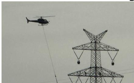
Jetzt wird es spannend. Der erste Hubschrauber flog über die neue 380 KV-Masten um die Zugseile für die Kabel einzuhängen. Eine Sisyphos-Arbeit, bei der höchste Konzentration durch den Piloten gefragt ist und natürlich für den, der
