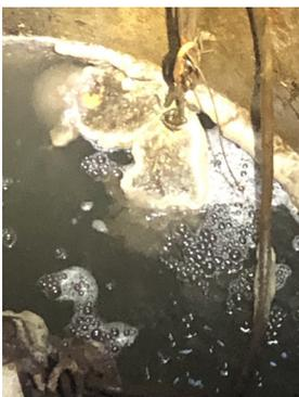
Auch hier ist, wie in anderen Hebeanlagen, das Problem, dass Fett die Hebeanlage schädigt. Bitte, bitte schüttet kein Fett in den Abfluss, sondern wischt Töpfe und Pfannen vorher mit Haushaltspapier aus.
